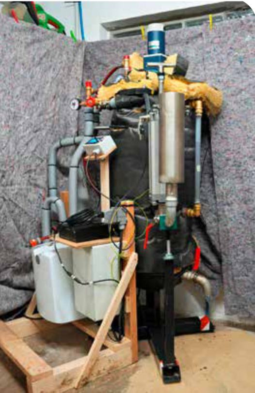
Gesamtansicht der Biogasanlage.
