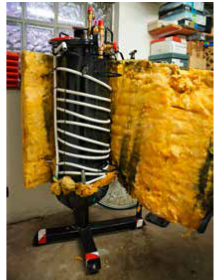
Behälter unter der Isolierung.
